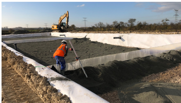
Le chantier de la station d'épuration
